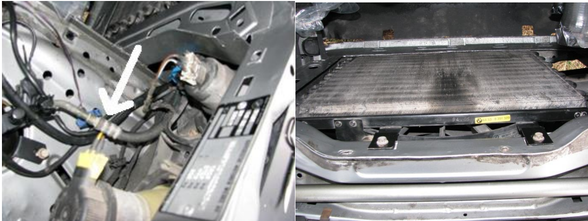
Slika: Na levi sliki speljana gibljiva cev do sušilnega filtra (označena s puščico), na desni vgrajen kondenzator.
