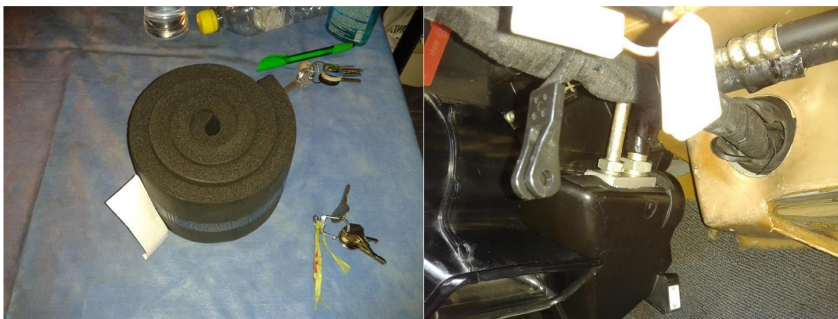
Sliki: na levi izolacijska pena, na desni končen izgled skupaj s cevmi in izolacijo okrog ventila
